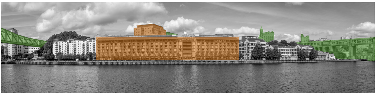
تصویر ۶: نشانه‌های بصری در تراز پایین دید، حدفاصل پل‌های لول (سمت راست تصویر) و پل مترو (سمت چپ تصویر). عکس: گوران عرفانی، ۱۳۹۵.
