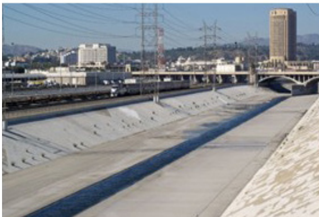
تصویر ۲. تاب‌آوری مهندسی رودخانه لس آنجلس در برابر سیلاب ۱۹۳۸ و کانالیزه کردن رودخانه. مأخذ: www.nextcity.org
