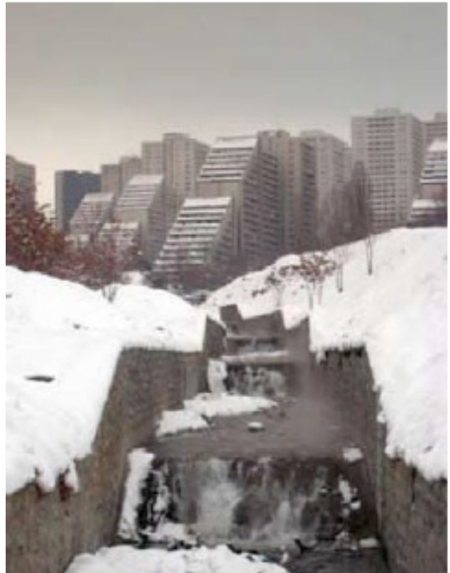
تصویر ۱. تراس‌بندی و کانال‌کشی رودخانه در که. مأخذ: سبکرو، ۱۳۹۸.
