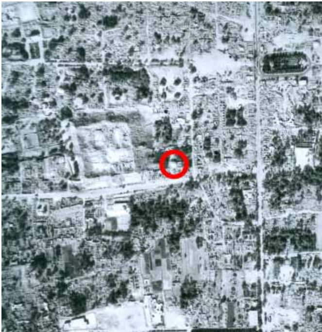
۲: چند روز پس از زلزله ۱۳۵۷، آب انبار های سالم در میان ویرانه های شهر، سایه چندین گنبد پابرجا پس از زلزله بر زمین مشهود است. مأخذ: سازمان نقشه برداری.
