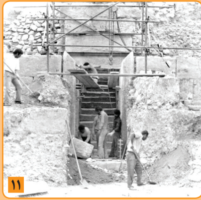
عملیات مرمت ورودی که به علت رانش دچار تخریب گشته بود
