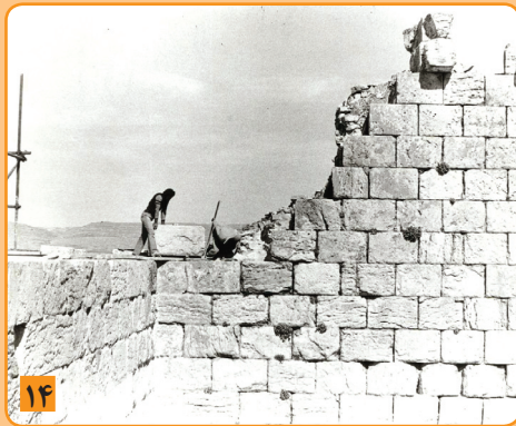
عملیات مرمت ورودی که به علت رانش دچار تخریب گشته بود
