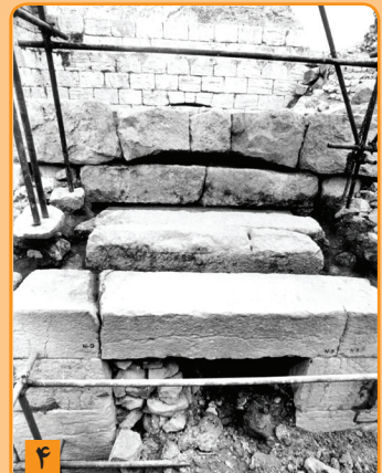
قطعه ای از سنگ تاج در گاه جنوبی معبد که هنگام عملیات خاکبرداری از روی کف ظاهر و با قلیقه درگیری که در کنار آن به دست آمده بود وضای وبعنا نصب گردید. شیار هلی این تاج که برای اولین بار در این بنا مشخص شد تقلید و الهامی است از بنای تخریب تخت جمشید هنگام عملیات خاکبرداری از روی کف ظاهر و با قلیقه درگیری که در کنار آن به دست آمده بود وضای وبعنا نصب گردید. شیار های این تاج که برای اولین بار در این بنا مشخص شد تقلید و الهامی است از بنای تخریب تخت جمشید.
