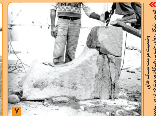
مرمت اصلاح معبد آناهیتا که از سطح زمین های اطراف در حدود ۸ متر بلند تر بوده است و پر کردن فاصله های دو جدار داخلی و خارجی با گچینه و دوغاب گچ
