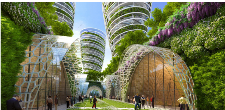
تصویر ۱: پروژه پیشنهادی شهر سبز پاریس در برنامه «Paris Smart City 2050»، طراحی در منطقه ۱۴ شهر تصور شده و به‌دنبال تولید ساختمان‌های مرتفعی است که تولیدکننده انرژی‌های مثبت و پاک‌کننده هوا از آلودگی و هماهنگ با محله باشند. ایده مشتمل بر طراحی کربدوری اکولوژیک به طول ۲۳ متر واقع بر گذرگاه راه‌آهن قدیم روی محل کمربندی کوچک شهر (Petite Ceinture de Paris) است. مأخذ:
