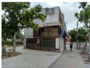
تخریب بناهای های تجاری متروکه در امتداد خیابان صاحب جمع
